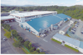
クレート第二工場
